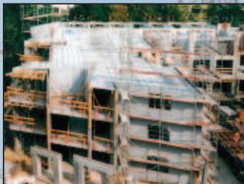
Монтаж двойных стен
