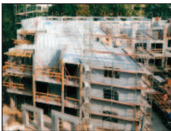
Монтаж элементного перекрытия
