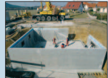
Двойная стена с внутренней изоляцией
