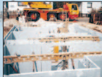
Монтаж двойной стены (подвальный этаж)
