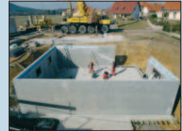
Двойная стена с внутренней изоляцией
