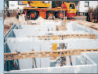
Монтаж двойной стены (подвальный этаж)
