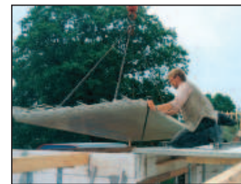
Монтаж элементных перекрытий и двойных стен
