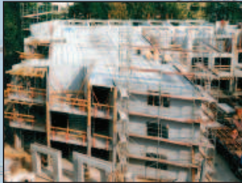
Монтаж двойных стен
